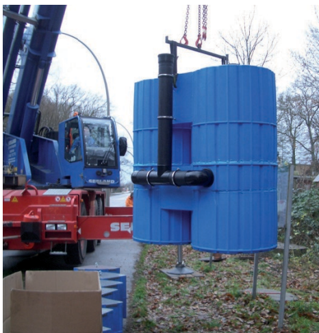
Hydrosystem 2000 på väg att lyftas på plats i brunnen.
