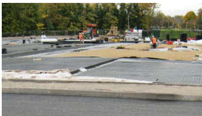
Fördröjning, 4-8 moduler högt = 20-40 cm
