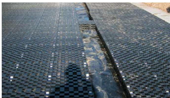
Fördröjning, 4-8 moduler högt = 20-40 cm
